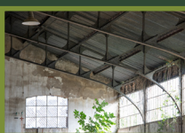
Détail de la charpente métallique du manège équestre de la caserne Andreossy, fin du 19 e s.
