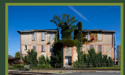
Bâtiment d'alimentation de la Compagnie des chemins de fer du Midi dit « le Beffroi », seconde moitié du 19 e s.
