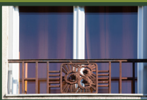
Décor de fleurs, détail d'un garde-corps de l'immeuble Richard, avenue Marceau Hamecher, architecte Louis Tardy (1931)
